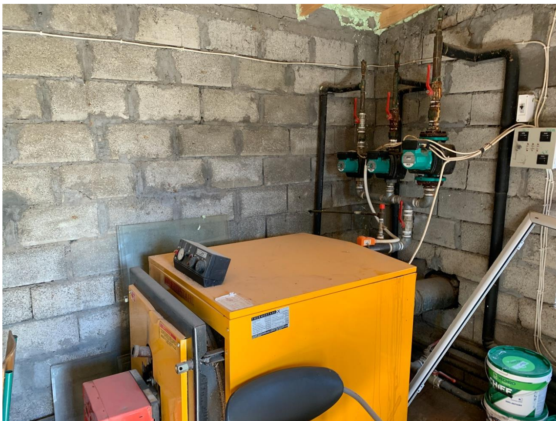
Σχήμα 1. Μονάδα λέβητα-καυστήρα ΔΣ Μεγάλου Δερείου
